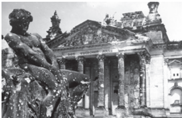
1945: Berlin liegt in Trümmern, das Reichstagsgebäude ist schwer beschädigt
